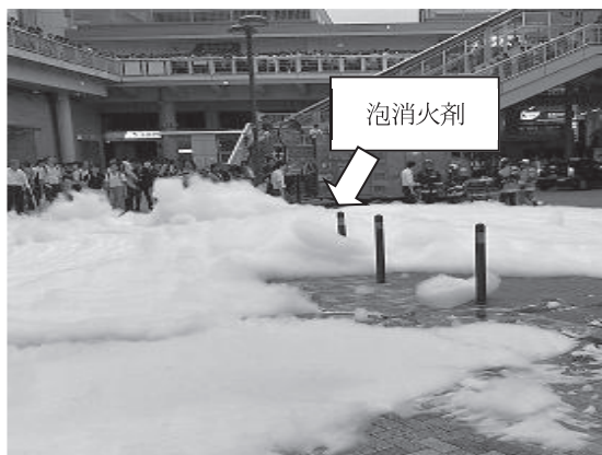
消火設備の泡消火剤が路上から河川へ流出
